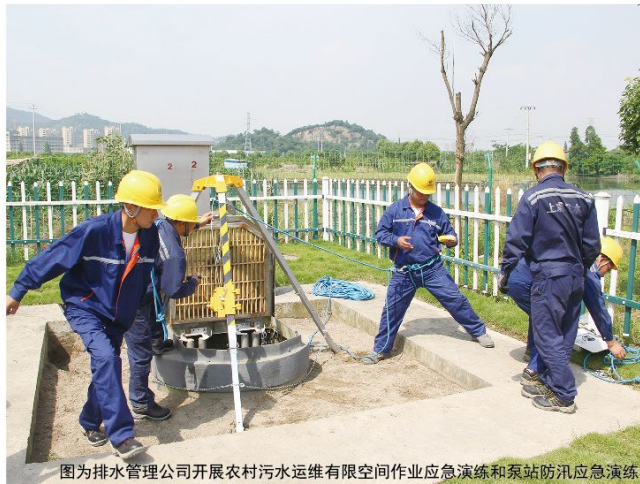
图为排水管理公司开展农村污水运维有限空间作业应急演练和泵站防汛应急演练
