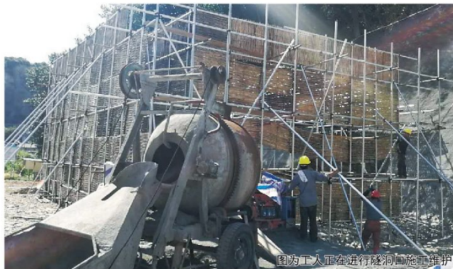
图为工人正在进行隧洞施工维护
