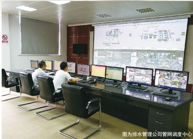
图为排水管理公司管网调度中心
